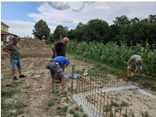
Priprema armature za izgradnju staklenika.
