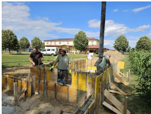
Izgradnja staklenika za vrtlarske radionice.
